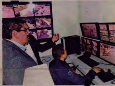
Se constató la instalación de más de 100 cámaras de vigilancia.
