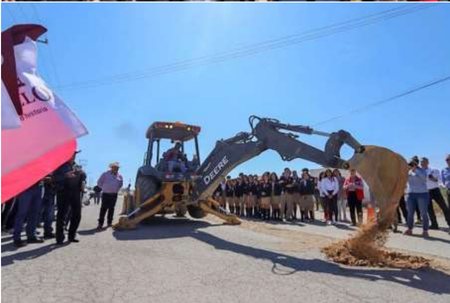
REHABILITACIÓN DE CALLE “TECNOLÓGICA”, 29 DE MAYO DE 2023.
